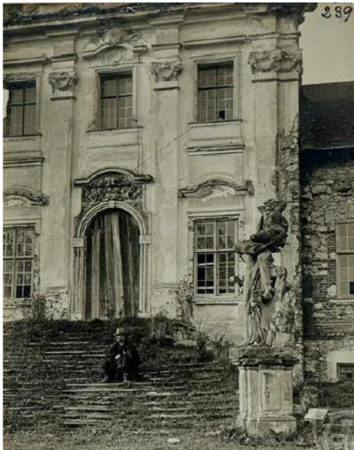
Ilustracja 8: Pałac w 1916 r., fotografia archiwalna.
